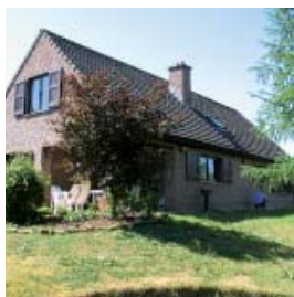
SITUATION AVANT TRAVAUX
