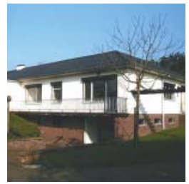
SITUATION AVANT TRAVAUX
