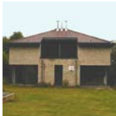
SITUATION AVANT TRAVAUX
