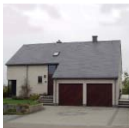
SITUATION AVANT TRAVAUX
