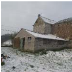
SITUATION AVANT TRAVAUX
