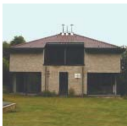
SITUATION AVANT TRAVAUX
